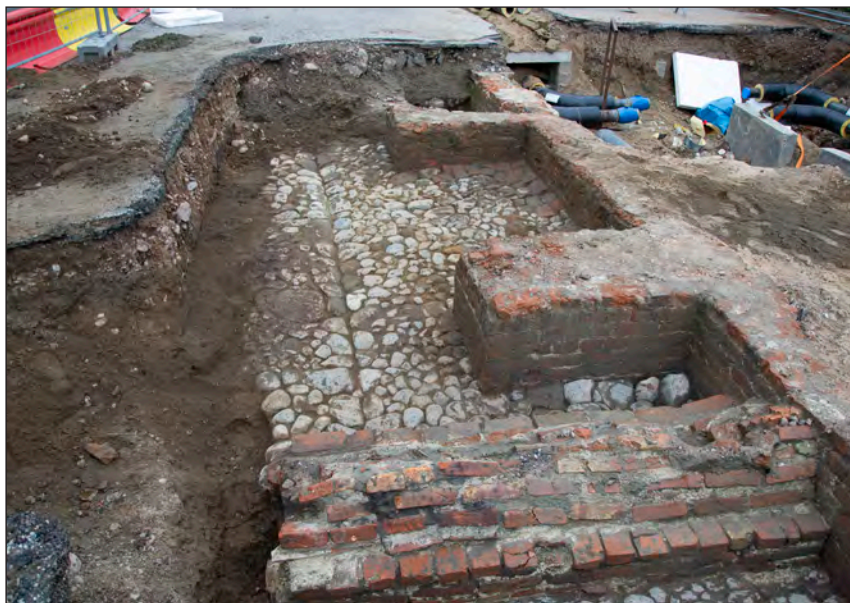
Strandmuren med två av strävpelarna, tegelavlopp och en stenläggning och väg med rännal. Foto: Fredrik Larsson.
